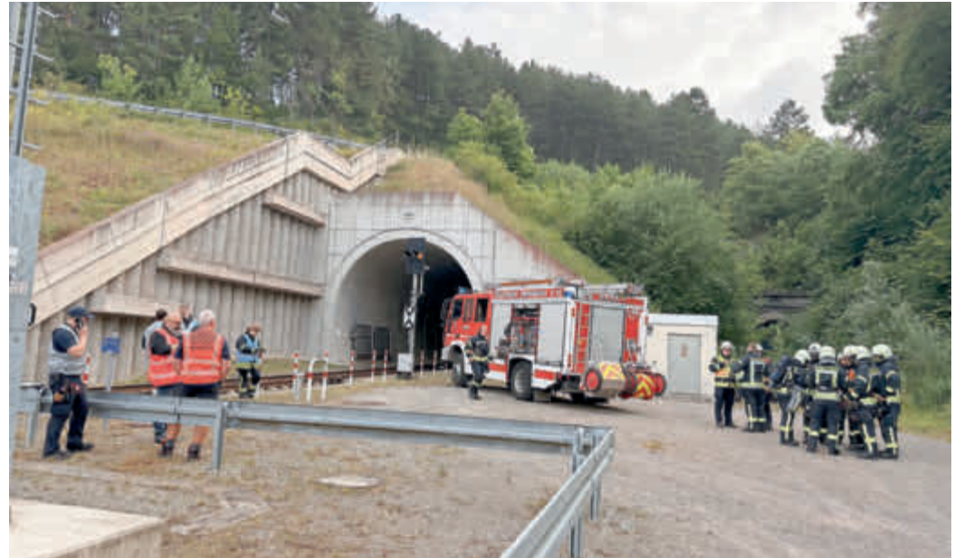
Alle in Bereitschaft: Vor dem Tunnel stehen Einsatzkräfte und Einsatzfahrzeuge für die Alarmübung bereit. Fotos: Monika Wüllner
